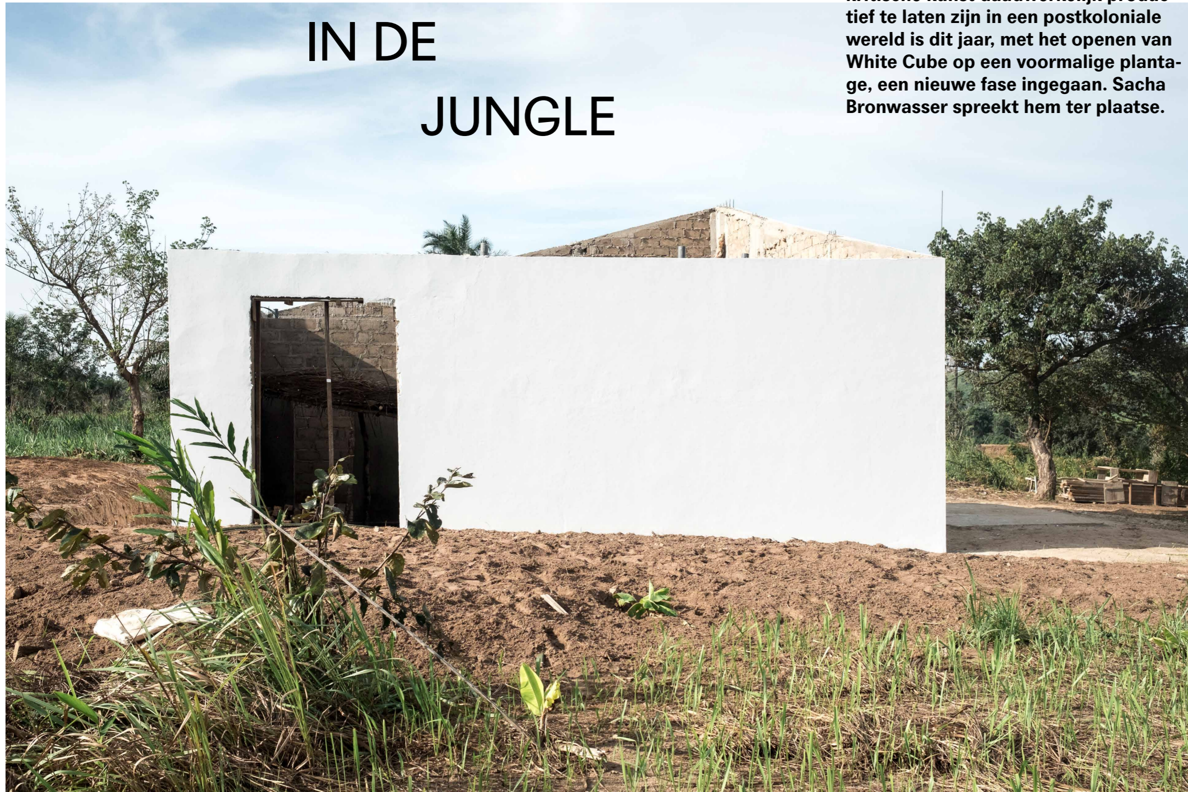
Zijaanzicht van de White Cube in aanbouw, foto Léonard Pongo
